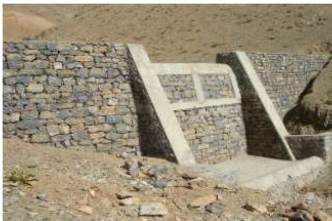
شکل ۳- نمایی از بند رسوب گیر گابیونی
