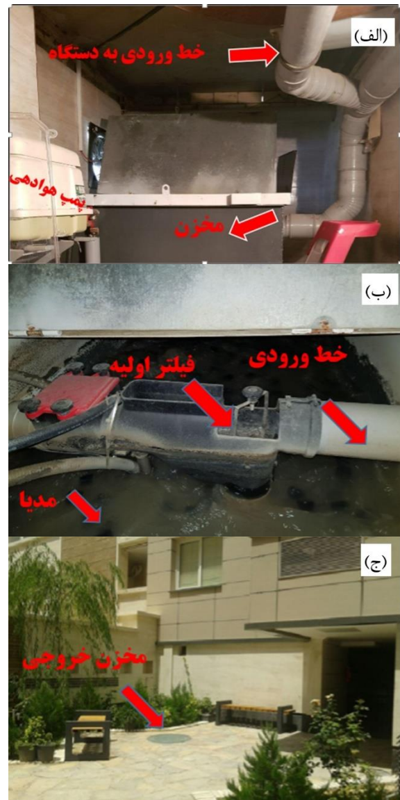
شکل ۱- اجزای آن سیستم بازچرخانی آب خاکستری: الف) خط ورودی، ب) مخزن ورودی، و ج) مخزن خروجی (Zare Ghanat Novi 2018).
